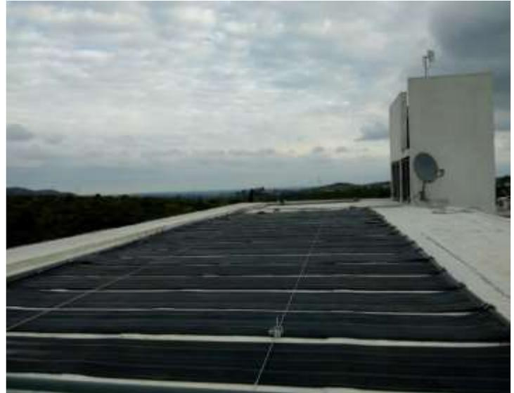
de acero forradas cada 50cm, el primer alambre ubicarlo a 10cm de los tubos de conexiones.
